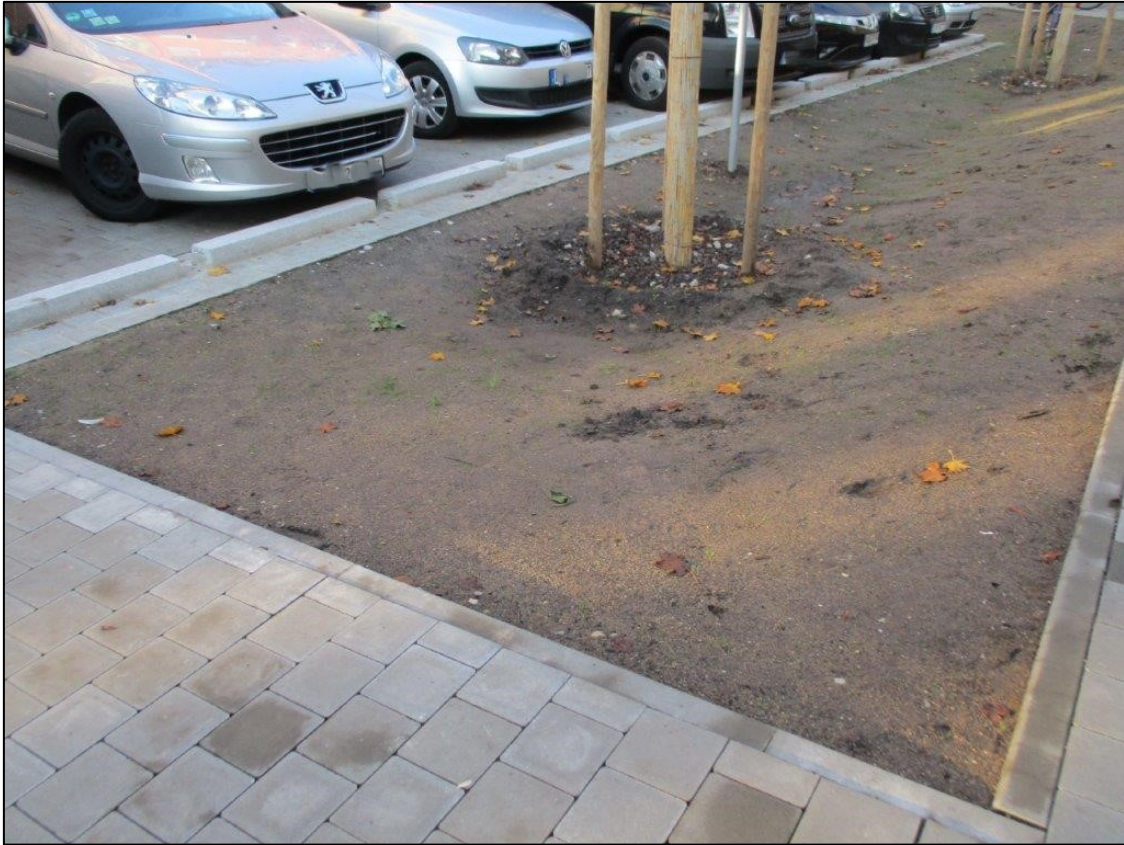
Abb. 9: Einleitung von Niederschlagswasser in ein bepflanztes Mulden-Rigolen-System im Stadtgebiet Nürnberg
