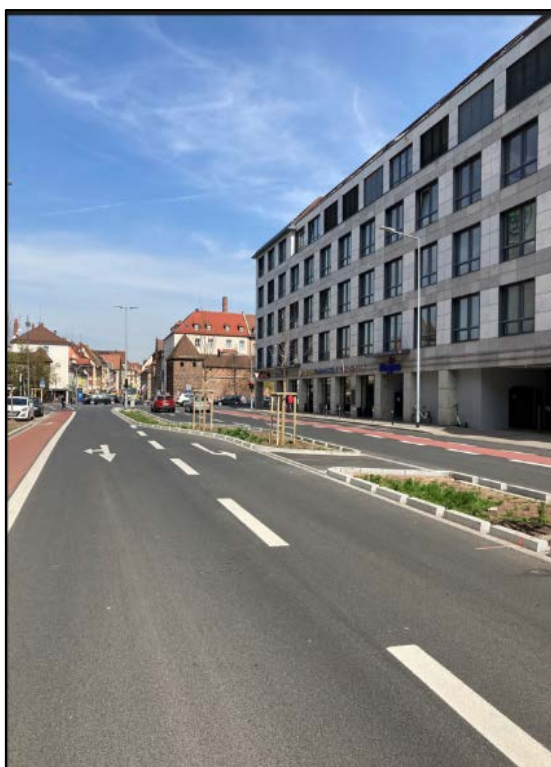
Abb. 7: oberflächige Ableitung über Bordsteinlücken in Mulden im Siedlungsgebiet Stadt Nürnberg (Quelle Stadtverwaltung Nürnberg)
