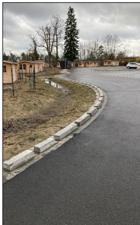
Abb. 7: oberflächige Ableitung über Bordsteinlücken in Mulden im Siedlungsgebiet Stadt Nürnberg (Quelle Stadtverwaltung Nürnberg)
