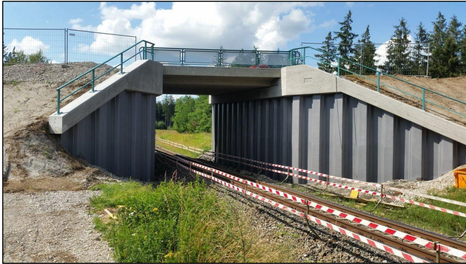
Abb. 6: Bahnbrücke Bobingen-Kaufering bei km 21,538 20 : Spundwand als Brückenwiderlager
