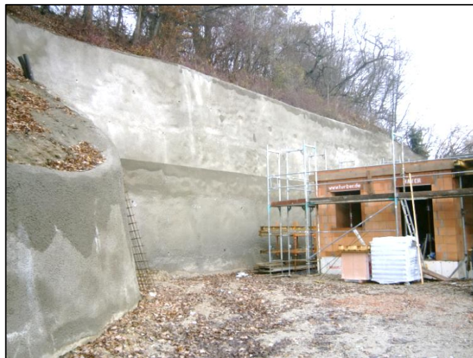
Abb. 7: Nagelwand als dauerhafte Hangsicherung
